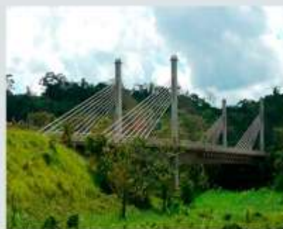
El puente sobre el Río Acre se inauguró en 2005. Está en la frontera entre Brasil y Perú. Su construcción fue el impulso clave de este proyecto transnacional.
